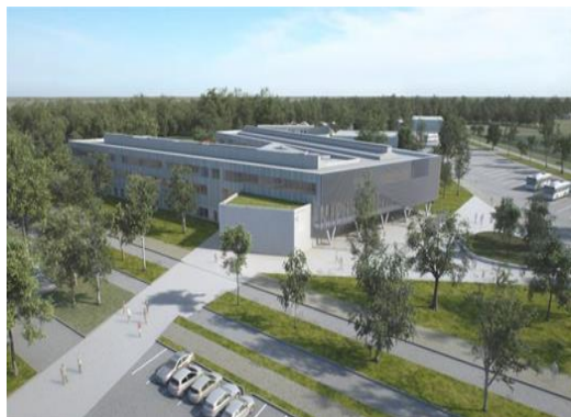
Photo : Projet du lycée de Nort-sur-Erdre - Etablissement retenu à l'appel à projet de l'ADEME «E+C», vise la certification de la marque NF « Bâtiments Tertiaires – Démarche HQE® (haute qualité environnementale)
